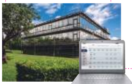
Sistema de gestão de edifícios (BMS)
